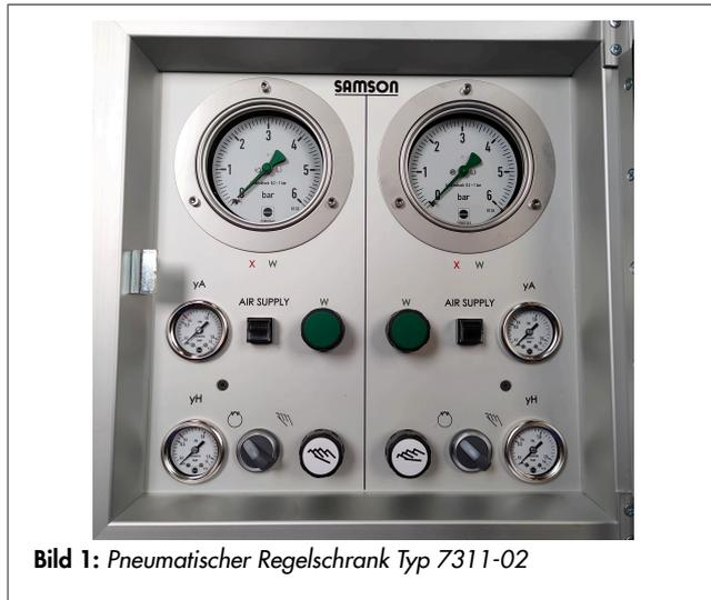
Bild 1: Pneumatischer Regelschrank Typ 7311-02
