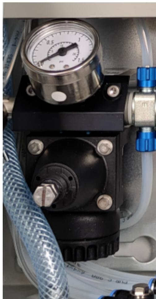
**Bild 21:** Druckregler für die Zuluft
