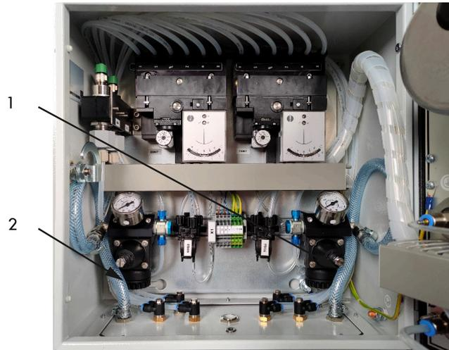
**Bild 20:** Aufbau des pneumatischen Regelschranks Typ 7311
