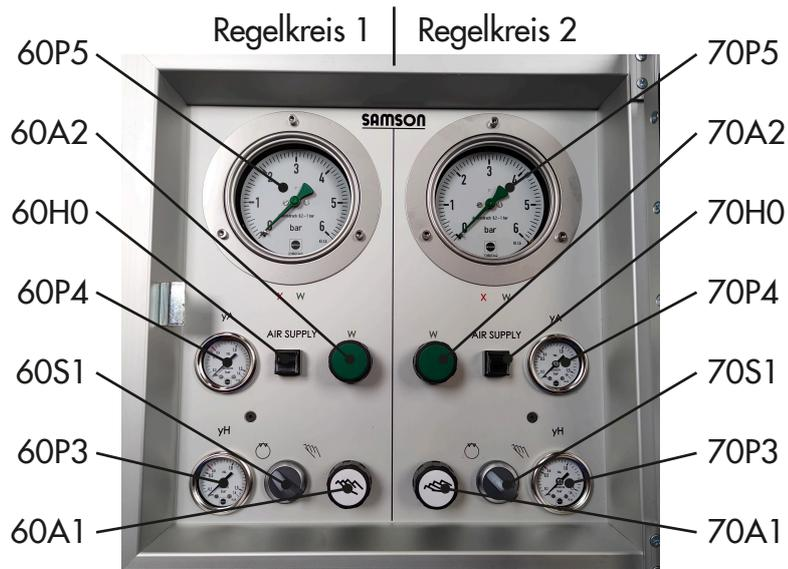
**Bild 3:** Pneumatischer Regelschrank Typ 7311-01/-02/-03 mit Anschlüssen
