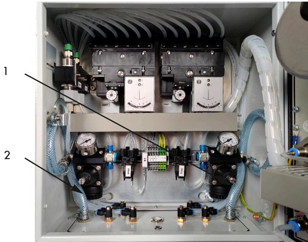
**Bild 16:** Aufbau des pneumatischen Regelschranks Typ 7311
